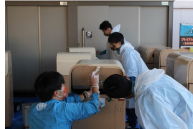
オペレーションセンター：ペンキ塗り
